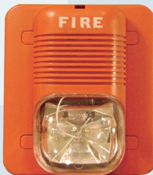
อุปกรณ์แจ้งเตือนด้วยแสง
